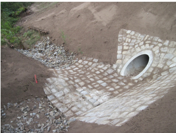
Abb. 2 Einlauf Durchlass bei Station 0+315
