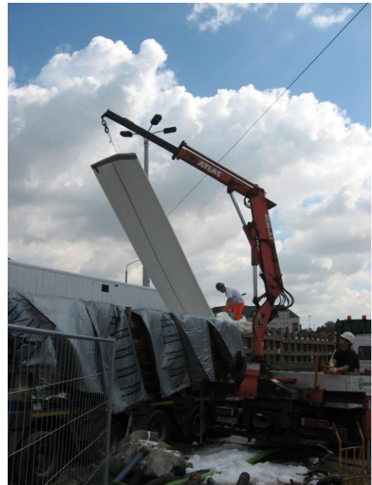
Abb. 1: Ausheben des vorkonfektionierten Liners aus dem Eisbett in Vorbereitung der Inversion
