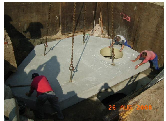
Abb. 2: Montage der Abdeckplatte auf dem Bauwerk 111C028
