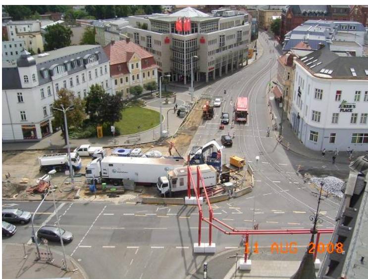
Abb. 3: Blick auf den Inversionsstartschacht im Brandenburger Platz einschließlich den Installationen zur Interimsentwässerung
