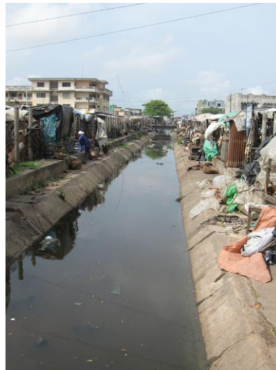
Offene Abwasserkloake, die mitten durch einen Markt fließt (Cotonou).
