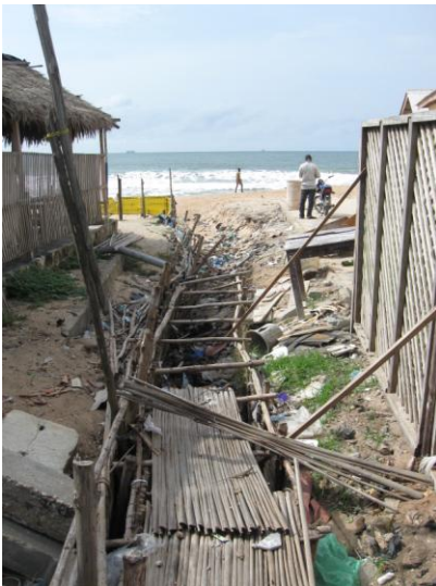
Drainage-Kanal mit direkter Ableitung in den Golf von Guinea (Cotonou).
